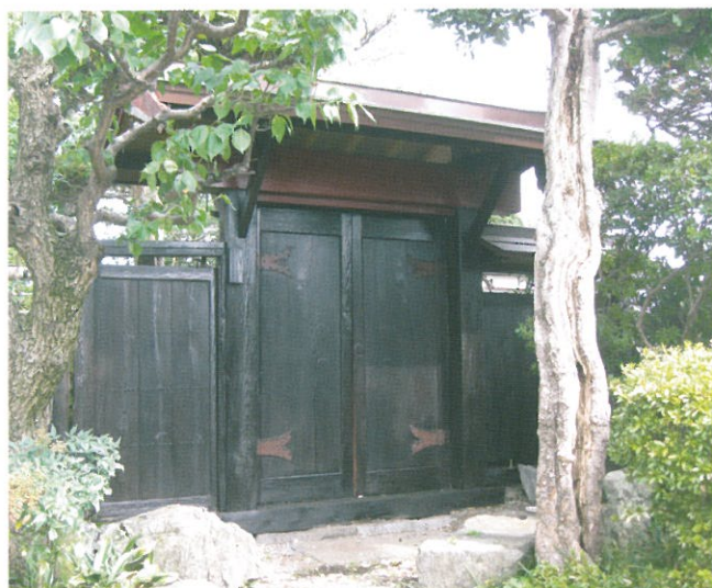
屋敷門改修工事【明治前半期民家】
