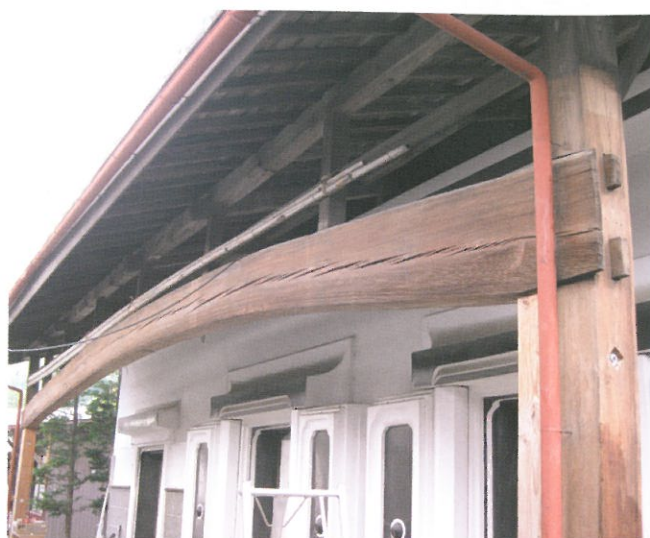
蔵梁補修工事【明治前半期民家】
