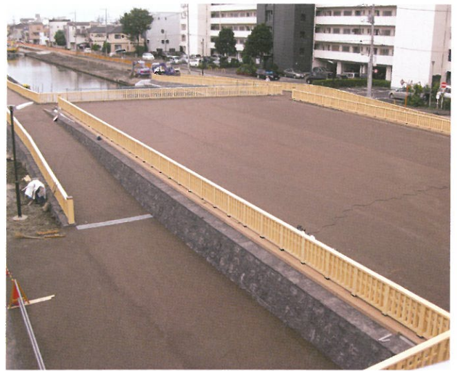
新川広場橋全景【東京都江戸川区】
