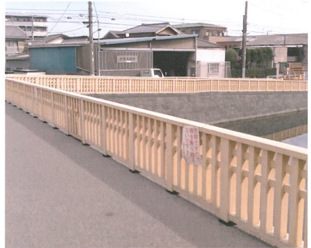
花見橋高欄【東京都江戸川区新川】
